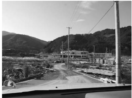
写真10 被災した雄勝町中心部（建物上にバス）
